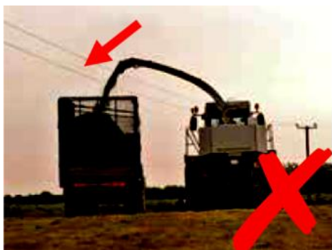
Kablllo elektrike të pa izoluara
