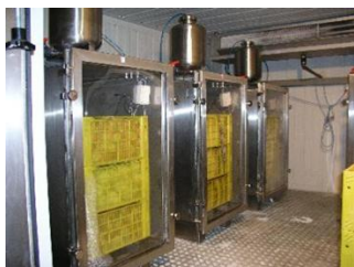
Camere frigorifice cu atmosferă controlată
