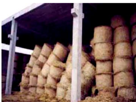
Piles trop hautes et non soutenues par des câbles transversaux entre les piliers
