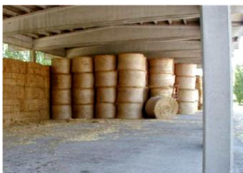
Cataste troppo alte e non fermate con cavi trasversali tra i pilastri
