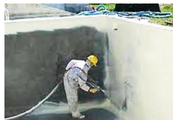
Zbiorniki na gnojowicę
